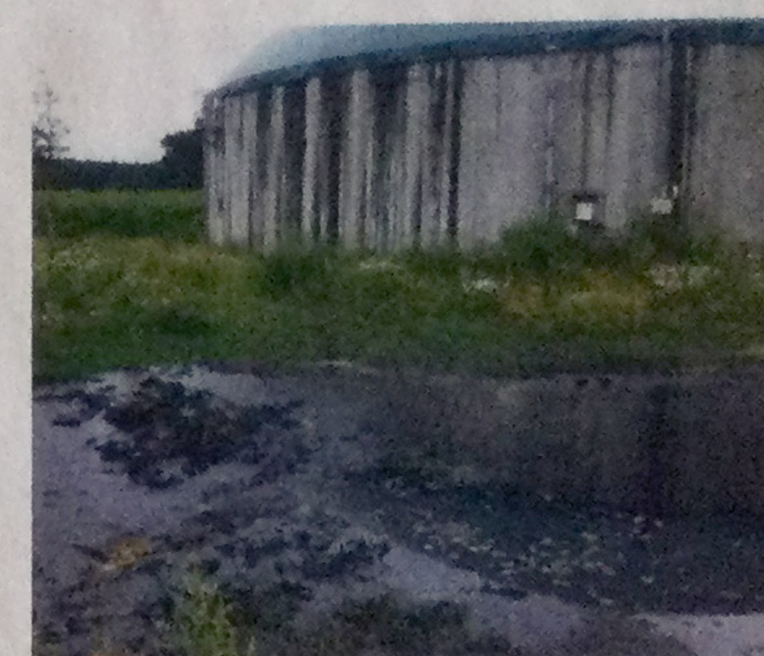
Güllebecken läuft über.
